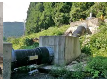
宇津尾谷川小水力発電所のフランシス水車(左)と導水管
