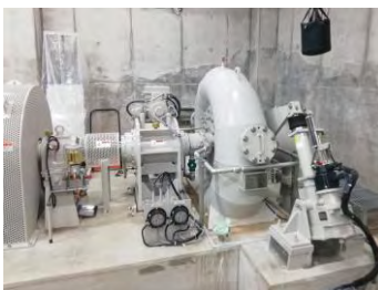
宇津尾谷川小水力発電所のフランシス水車(左)と導水管
