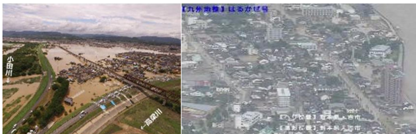
図1 平成30年7月豪雨による岡山県倉敷市の浸水被害(左)と令和2年7月豪雨による熊本県人吉市の球磨川水害(右) 出典：国土交通省(2024)
